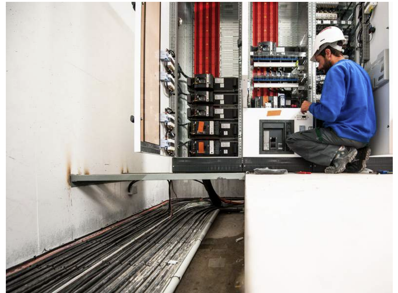
Chantier de l'hôpital de Moulins
