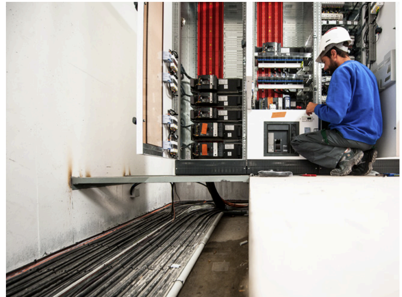
Chantier de l'Hôpital de Moulins
