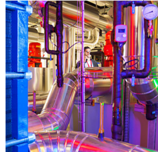
Contrôle et maintenance
